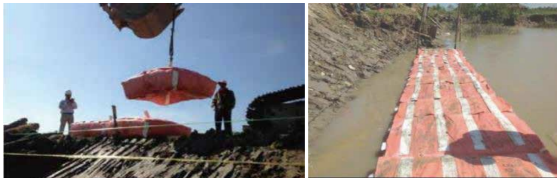
缅甸某河川的临时道路工程
