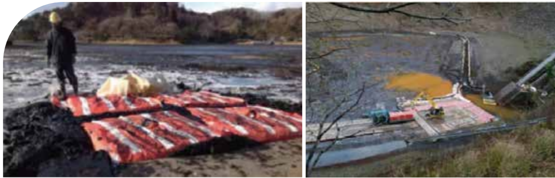
日本国内某公园湖心岛临时道路工程
