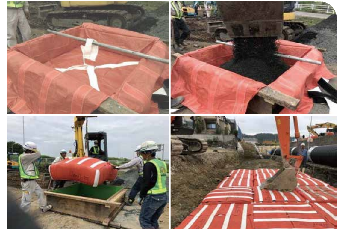
地构件装填铺设过程
