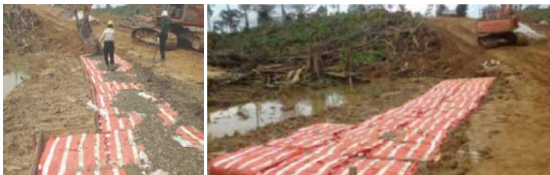
印度尼西亚加里曼丹岛的湿地软基上修建临时道路工程
