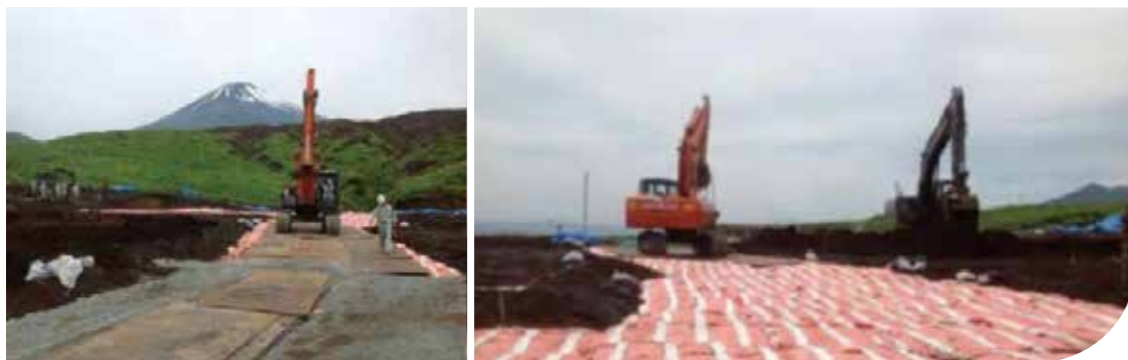
日本静冈县某结构建设的临时道路和施工场地工程
